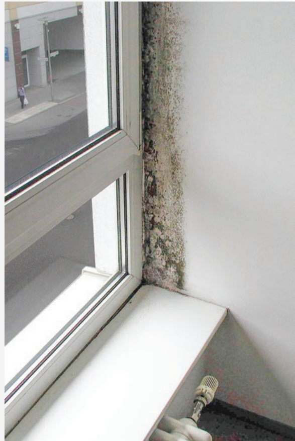
Відомий хід ізотерми 13 ° C. Смуга цвілі вказує, де мало бути встановлено вікно.
