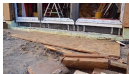
Fot. 15 Rozmieszczenie konsoli Knelsen FMW pod progiem zestawu okien Passiv-Line Ultra
