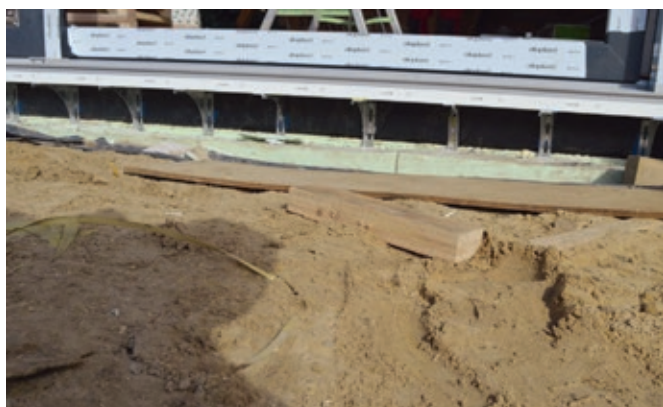
Fot. 10 Rozmieszczenie konsoli Knelsen SLW pod progiem drzwi balkonowych HST Passiv 85
