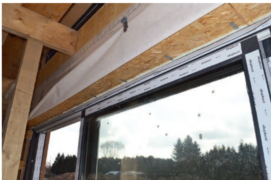
Fot. 12 Mocowanie mechaniczne ościeżnicy drzwi balkonowych HST Passiv 85 do ościeża przy użyciu kotew stalowych
