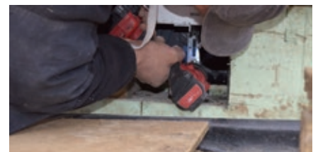
Fot. 8 Mocowanie konsoli SLW do czoła płyty fundamentowej
