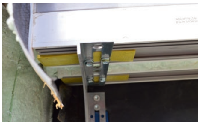
Fot. 11 Sposób mechanicznego połączenia konsoli Knelsen SLW z systemowym poszerzeniem
