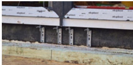
Fot. 16 Podparcie stojaków ościeżnic okien Passiv-Line Ultra
