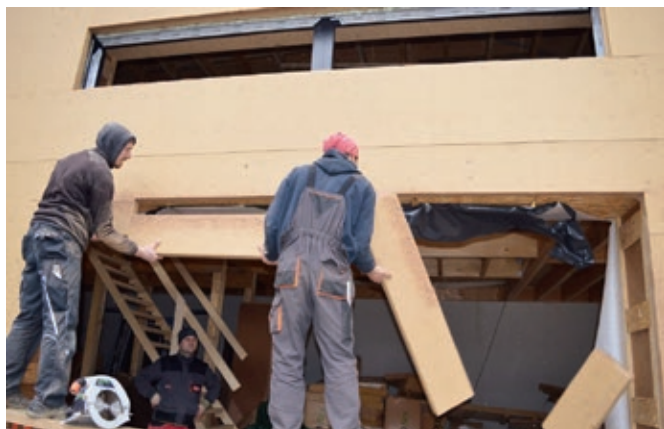
Fot. 3 Przygotowanie ościeża do montażu. Wymiarowanie płyt obudowy termicznej. Przycinanie płyt z naturalnego włókna drzewnego
