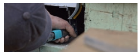
Fot. 9 Mocowanie konsoli SLW do elementów poszerzeń systemowych za pomocą nasadki kątowej 90°
