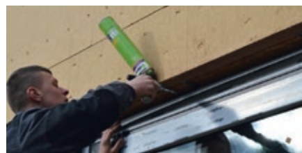
Fot. 19 Wykonanie warstwy termoizolacji szczeliny dylatacyjnej przy użyciu pianki PU
