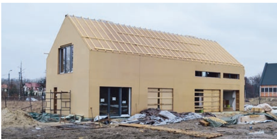
Fot. 1 Szkieletowy budynek pasywny w technologii STEICO
