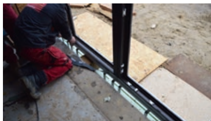
Fot. 14 Pozycjonowanie w ościeżu zestawu okien o różnej funkcjonalności
