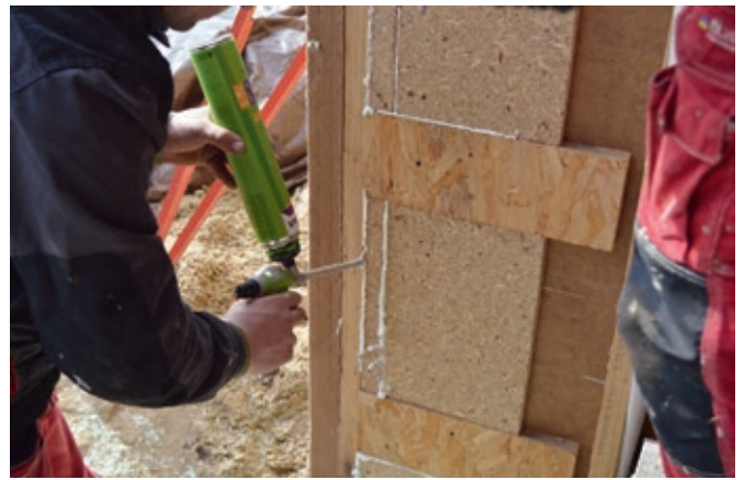
Fot. 5 Deskowanie - element wyrównania płaszczyzny ościeża Usuwanie nieszczelności deskowania
