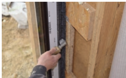
Fot. 20 Wykonanie warstwy paroizolacji przy użyciu folii
