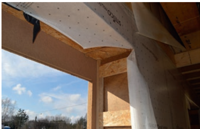
Fot. 2 Budynek szkieletowy drewniany, element nadproża ościeża nieprzygotowany do montażu
