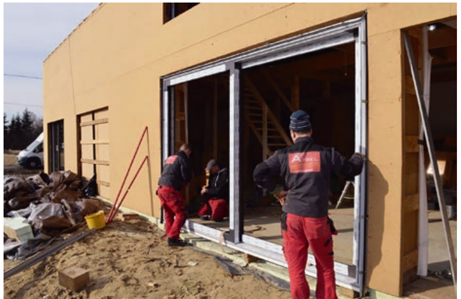
Fot. 6 Instalacja i pozycjonowanie ościeżnicy drzwi balkonowych HST Passiv 85 w ościeży
