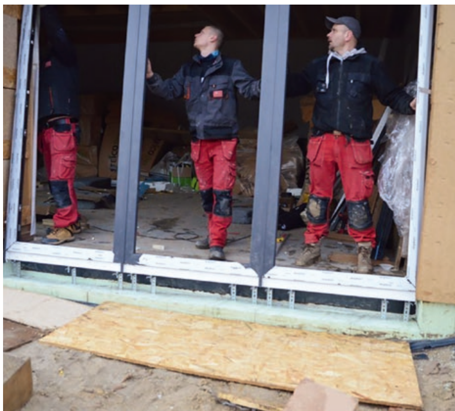
Fot. 13 Instalacja w ościeżu zestawu okien o różnej funkcjonalności
