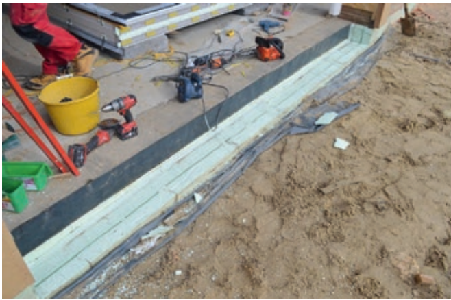
Fot. 4 Czoło płyty fundamentowej po usunięciu warstwy termoizolacji
