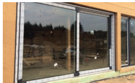
Fot. 21 Drzwi balkonowe HST Passiv 85 zainstalowane w budynku o szkieletowej konstrukcji drewnianej STEICO
