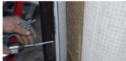
Fot. 17 Mocowanie mechaniczne ościeżnic okien Passiv-Line Ultra za pomocą śrub ramowych
